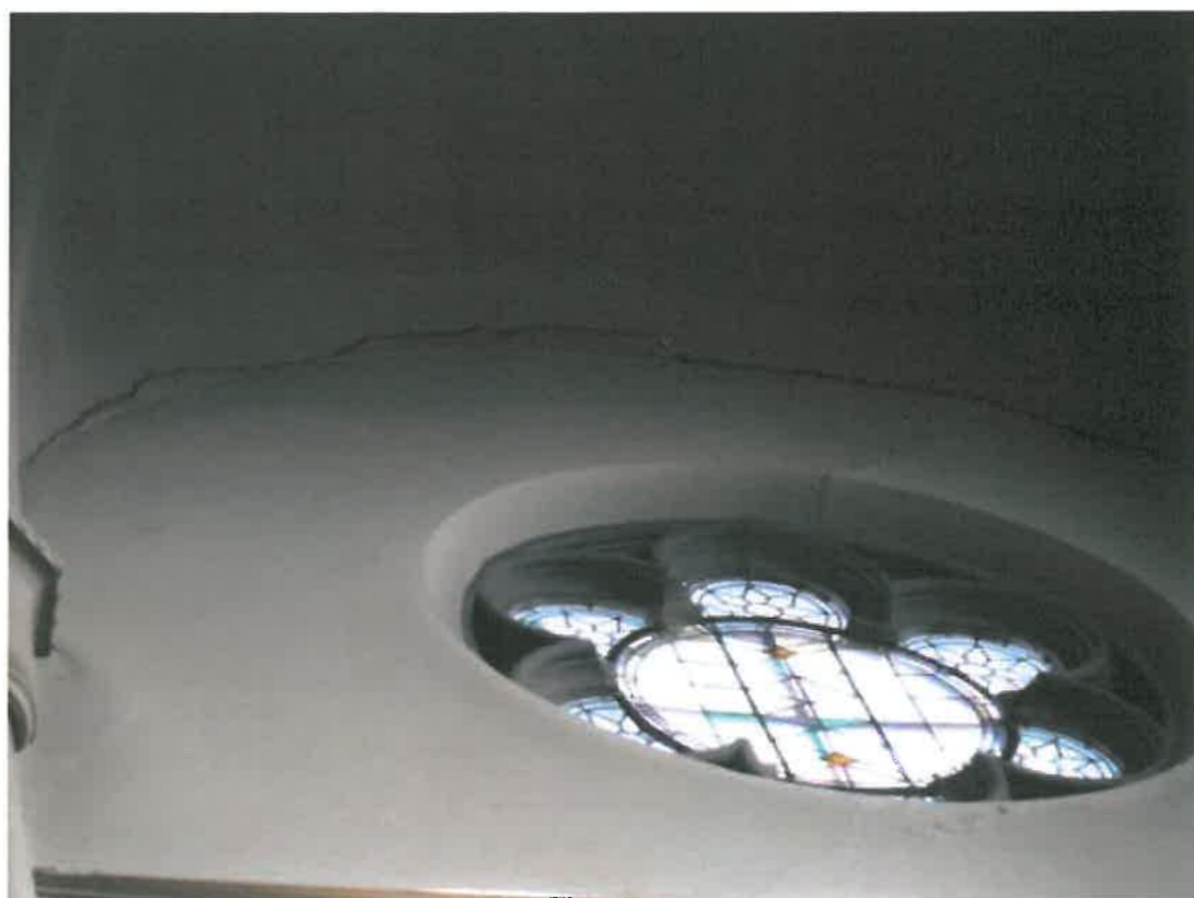
Foto 123 Scheur lang het plafond.
