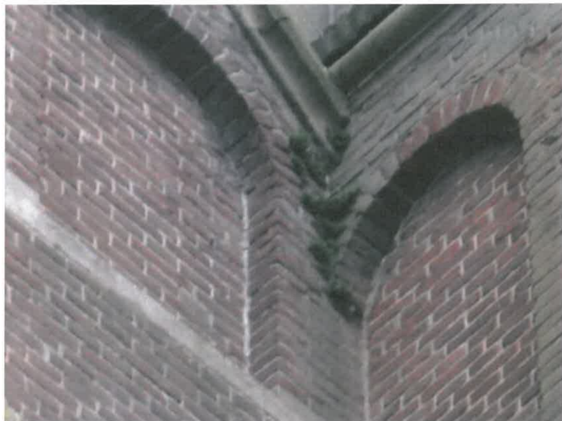
Foto 75 Begroeiing in de toren a.g.v. slecht voegwerk.
