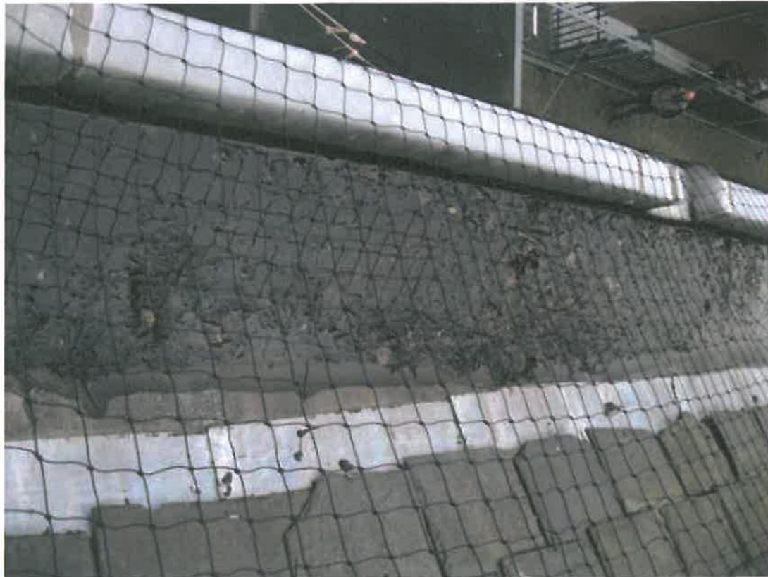
Foto 23 Slechte zinken dakgoot.
