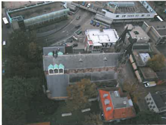
Aan de noordzijde van de kerk ligt het in 1991 gerealiseerde en in 2007 uitgebreide winkelcentrum Amstelplein met de hellingbaan van de parkeergarage die dicht langs de kerk loopt. Direct naast de kerk ligt het in 2008 gerealiseerde pand. Op de voorgrond naast de kerk de pastorie. Foto: Jan Matze
