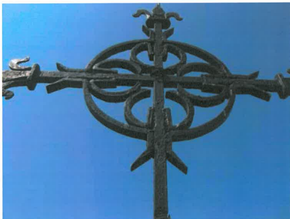
Foto 108 Ernstig gecorrodeerd kruis.
