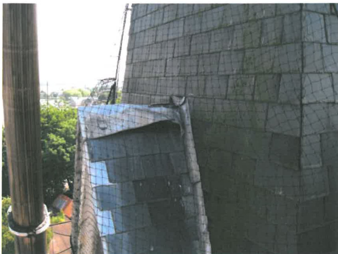
Foto 7 Gescheurd en opgewaaid noklood op een steekkap van de toren.
